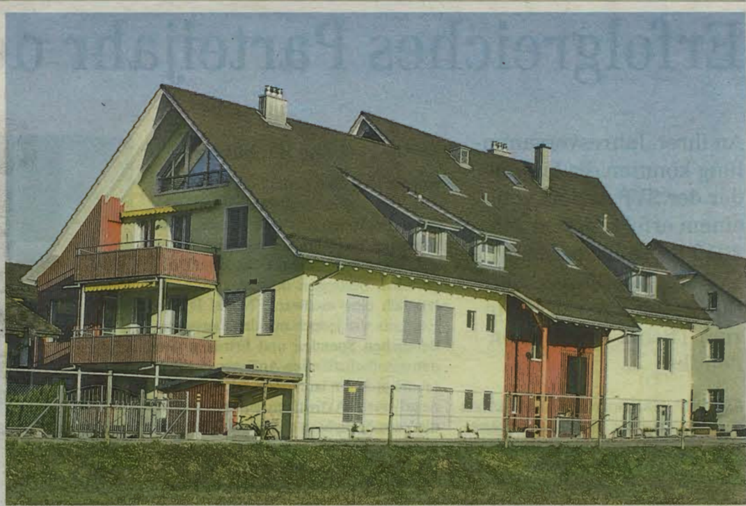
Ein Mehrfamilienhaus an der alten Schlosstrasse in Elgg.
